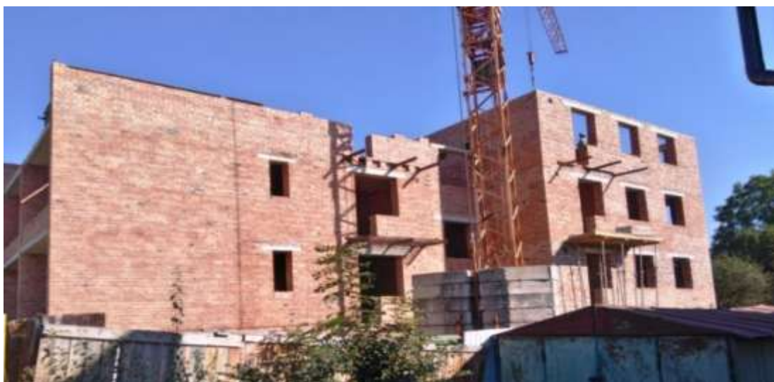
Рис. 2.47. Будівництво багатоквартирного будинку на вул. Церковна, 52. Джерело: https://pobudovano.com.ua/news/meshkantsi-tserkovnoi-u-frankivsku-zvinuvatili-predstavnikiv-dabi-u-bezdiynosti
