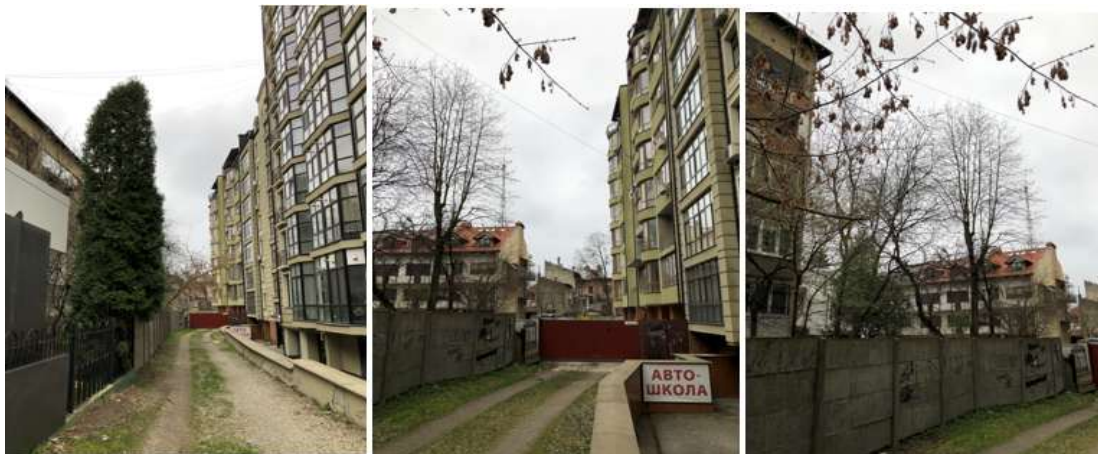
Рис.2. 53. Забудова багатоповерхівки на вул. Мазепи, 35а.
