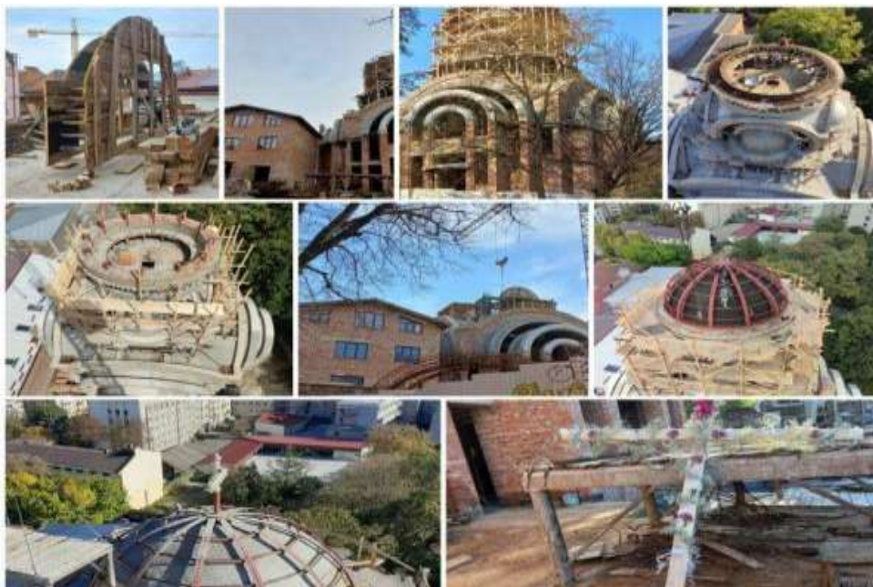
Рис. 2. 33. Фотографії стадій будівництва церкви на Валах. . Джерело: https://pik.net.ua/2023/02/05/use-tayemne-staye-yavnym-shho-kryyetsya-za-ogorozheyu-budivli-tserkvy-na-valah-u-frankivsku-foto/
