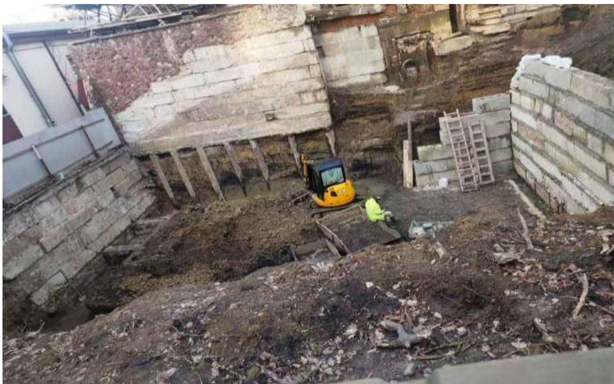
Рис. 2. 34. Хід будівництва церкви на Валах в історичному місці.
