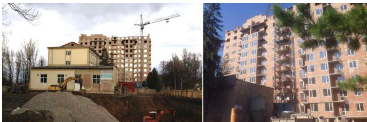
Рис. 2.14. Будівництво багатоквартирного будинку на вулиці Г. Мазепи 144.
