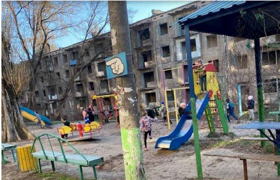
Рис. 2 Занедбана будівля (фотографія 2021 року)
