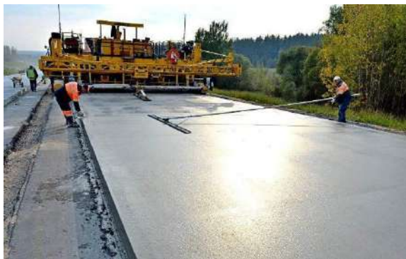
Рис. 3. Укладання доріг з фібробетону
