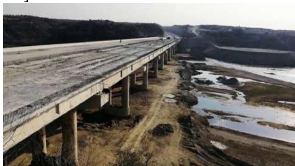
Рис. 4. Укладання мостів з фібробетону
