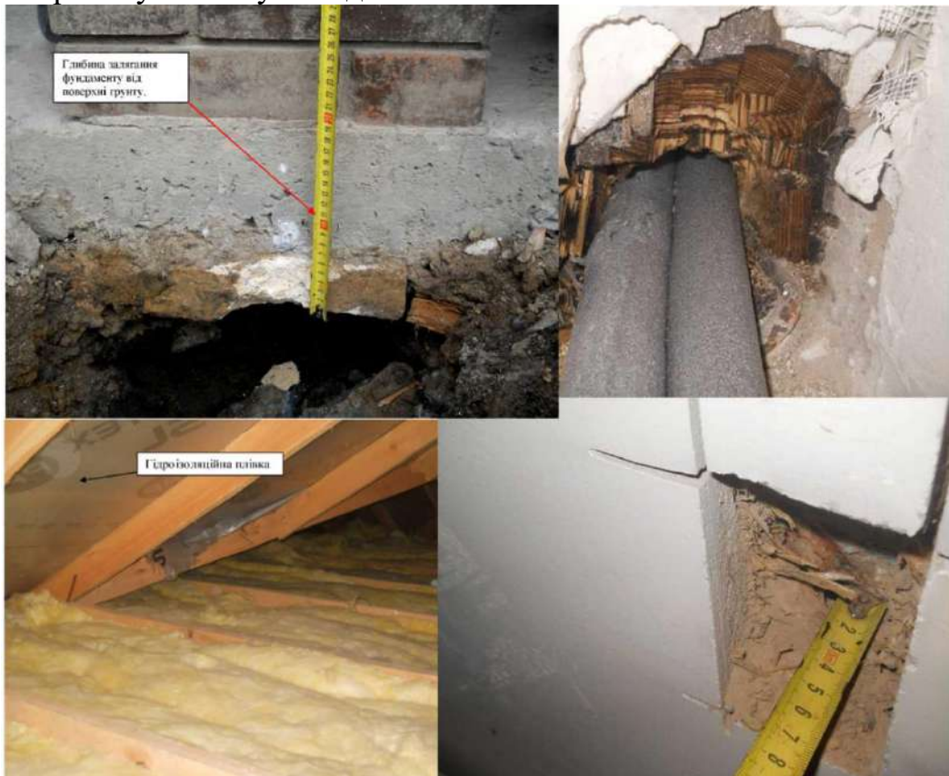
Рис. 1. Візуально інструментальне обстеження елементів будівлі
