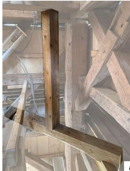
Рис. 3. а) фото дзвіниці під час обстеження несучого каркаса, 2016 р.; б) додатковий конструктивний елемент, встановлений з метою укріплення каркаса 2016 р. (Джерело: фото автора).
